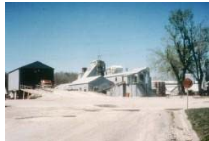
Rosiclare - Moderne Aufbereitungsanlagen Flotation, Trockner und Anlage zur Konzentration von Flussspat Foto: Alan Goldstein
