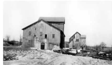
Flussspatgrube Rosiclare der Rosiclare Fluorspar Company; Schachthaus, im Hintergrund rechts Maschinenhaus Foto: Burchard E.F.; Anfang 20. Jh. - USGS Public Domain
